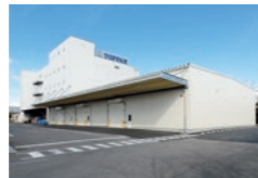
倉庫棟新築工事
