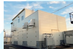
特別高圧変電設備新築工事
