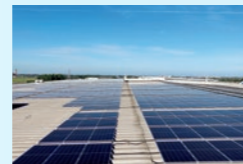
太陽光パネル設置(CM工事)
