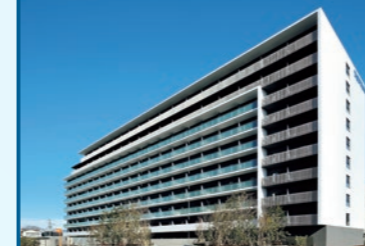
TOPPANハイツ西が丘 外観
